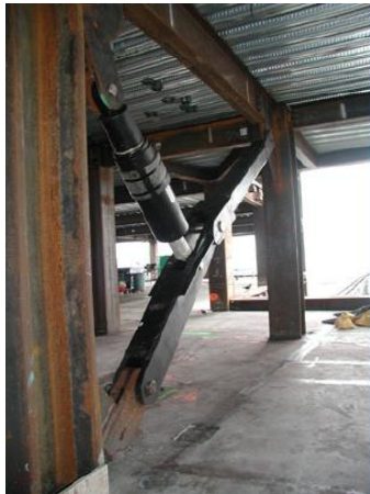
1.1. att. Enerģiju-izkliedējošas svārstību slāpētājsistēmas
