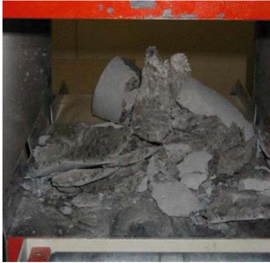
att.2.5 Sevišķi augstas stiprības betona bez šķiedrām sprādzienvēda sabrukums [19]
